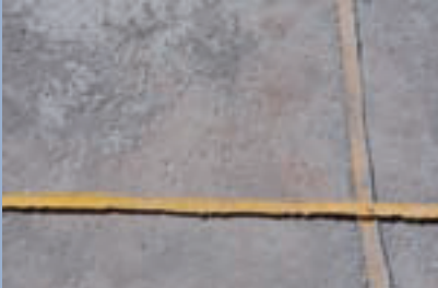
Distribución e introducción de plantillas de Piedra Antigua. Placing straps.
