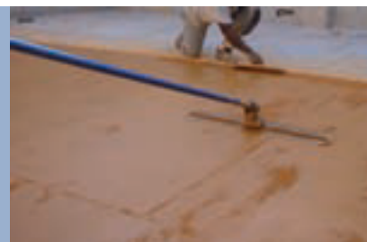
Alisado de rodadura. Espolvoreo de desmoldeante. Troweling hard. Applying release powder.
