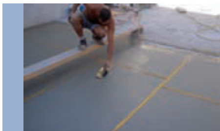
Alisado y extendido del hormigón en fresco. Distribución e introducción de plantillas con la llana de hormigón. Troweling green concrete placing straps by using concrete pool trowel.
