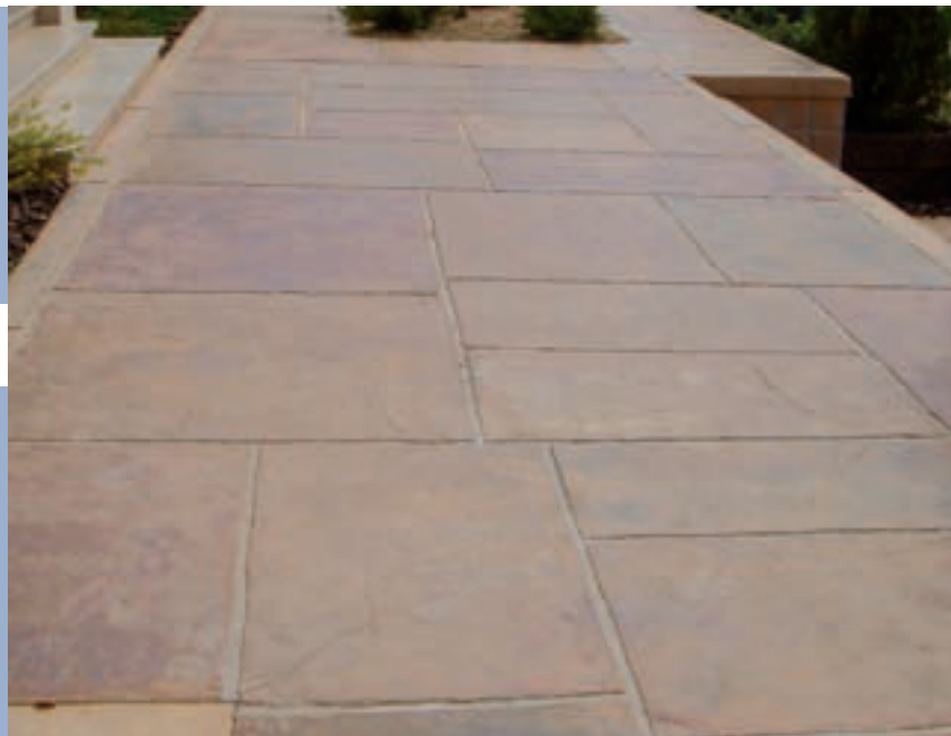
Pavimento terminado. Finished pavement.
