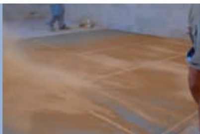
Capa de rodadura base. Applying initial hard.
