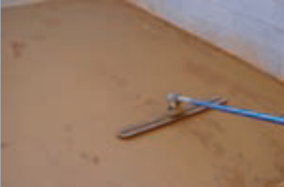
Base capa rodadura y pigmentación. Alisado de la rodadura. Espolvoreo de desmoldeante. Hard and pigment. Troweling hard. Application of release powder.
